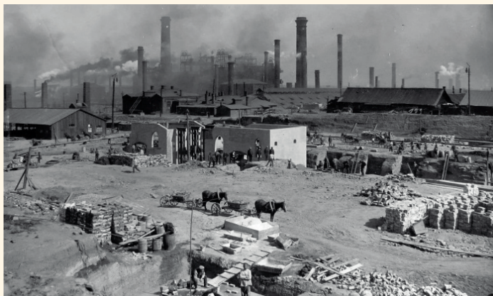
Строительство коксовых печей в Донбассе (1911 г.) (фото с сайта https://yandex.ru/images/search )
