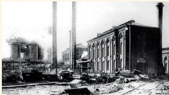
Развалины химического производства (1919 г.) (фото из открытых источников)
