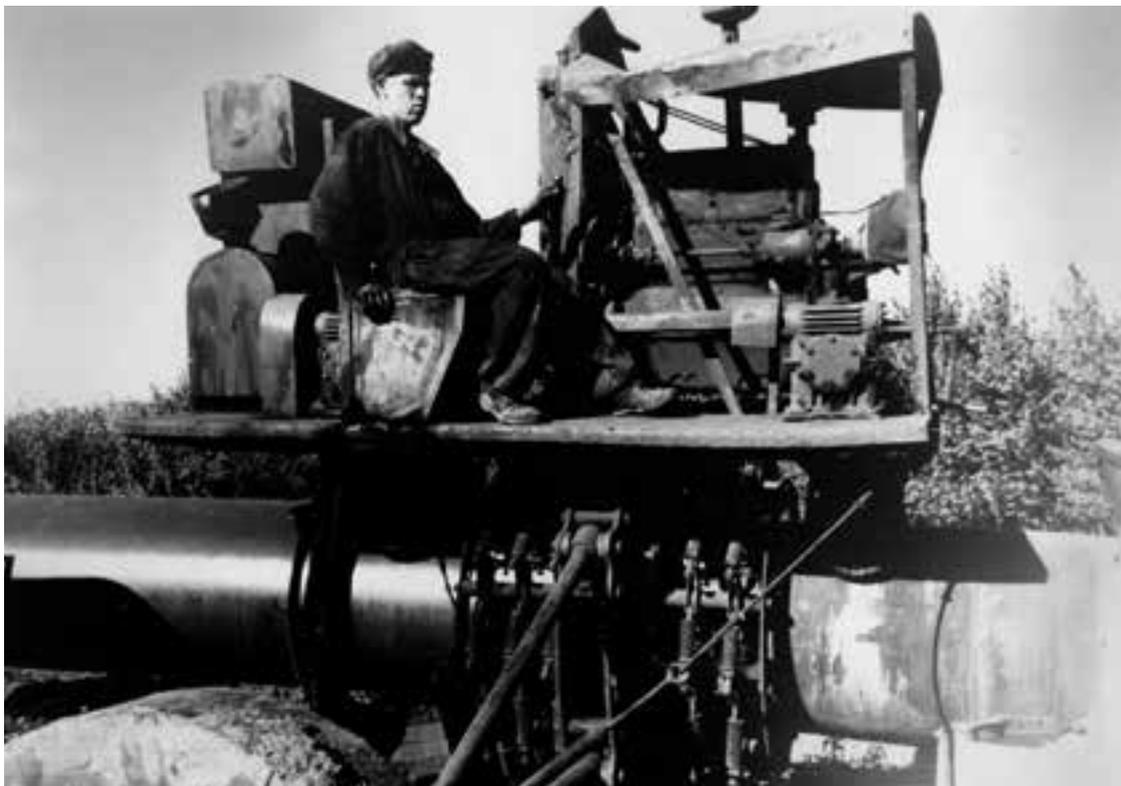
Одна из первых изоляционных машин, опробованных на газопроводе Дашава — Киев — Брянск — Москва.
