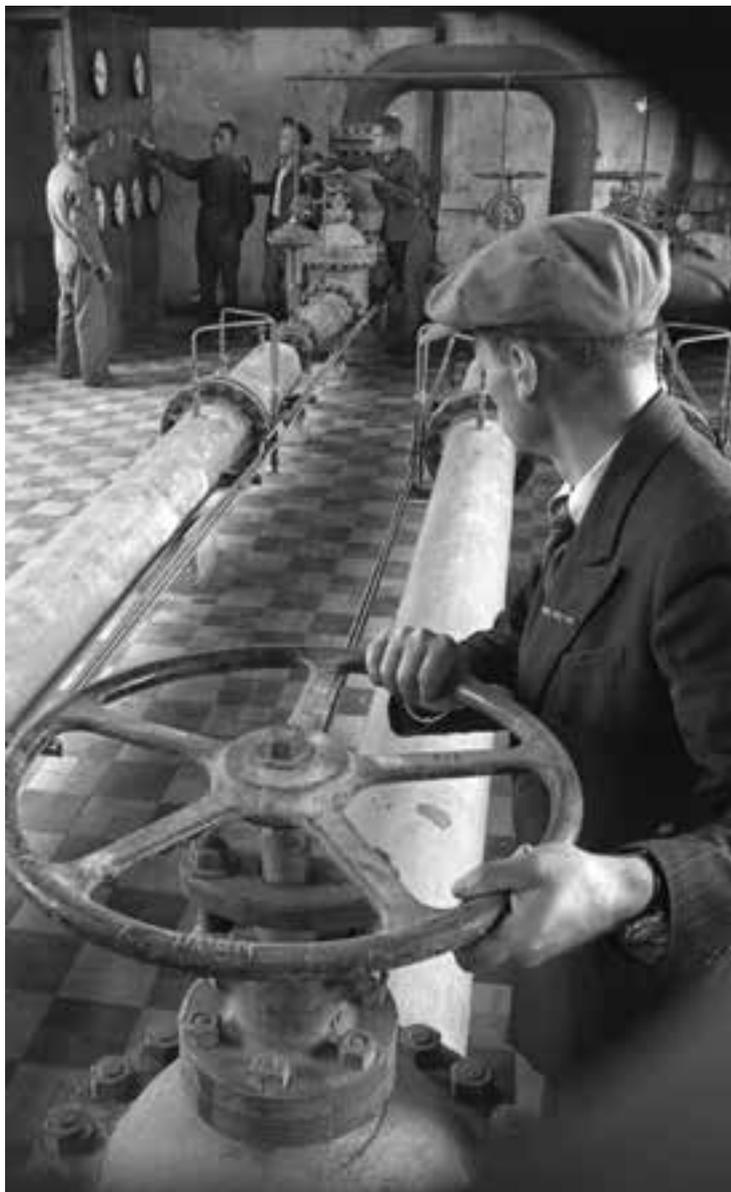
*Опробование механизмов на московской газораспределительной станции перед введением в строй газопровода Саратов — Москва*
