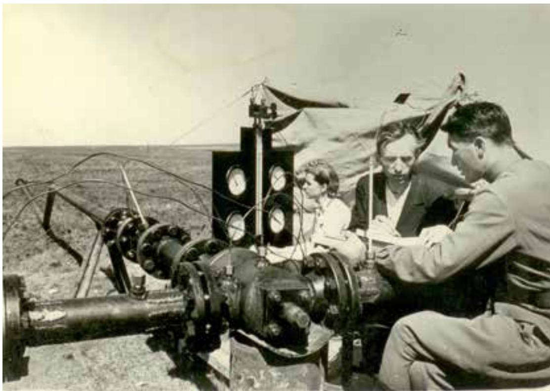
*Оборудование для извлечения газа из скважин слабого давления*
