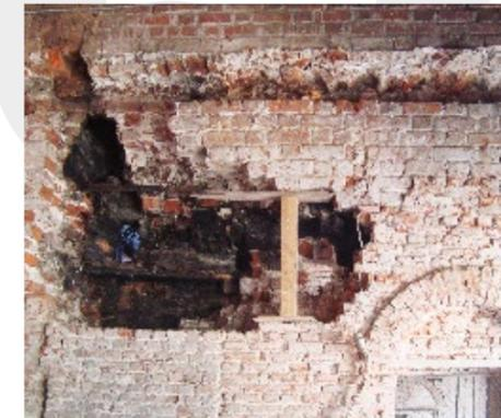
Обнаружение и раскрытие канала дымохода в ходе проведения вычинки. 2010 г.
