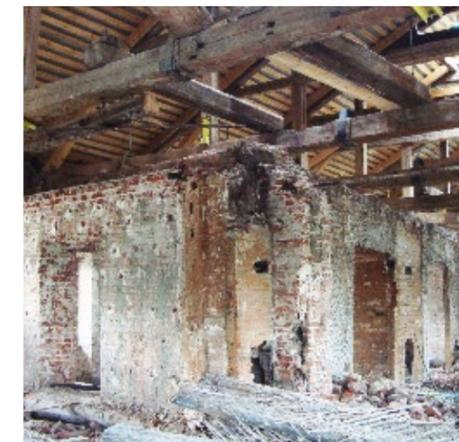
Фрагмент помещения 3-го этажа со стропильной системой чердака в процессе реставрации. 2010 г.
