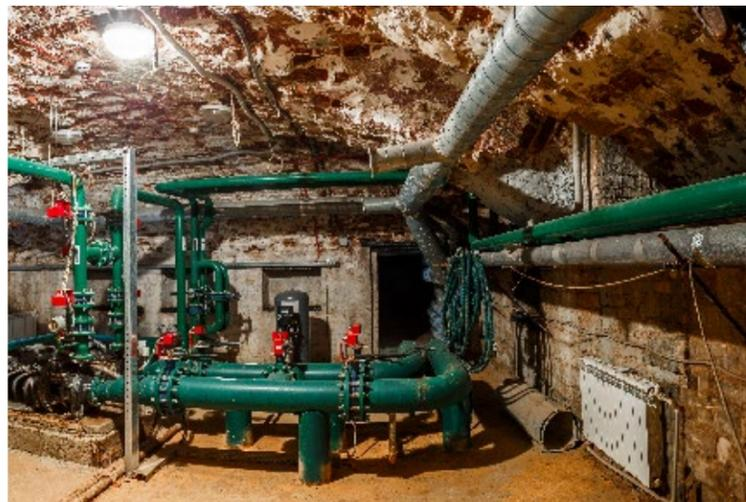
Подвальное помещение здания. Станция пожаротушения. Сохранены металлические кольца в своде. 2017 г.
