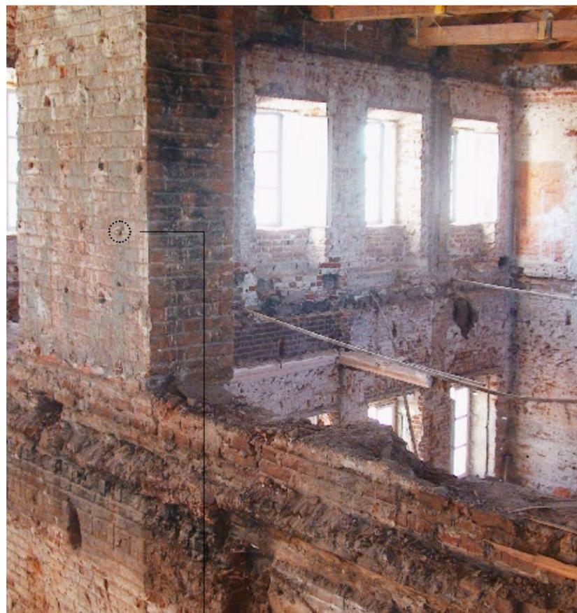
Демонтаж межэтажного перекрытия между 2 и 3 этажами
