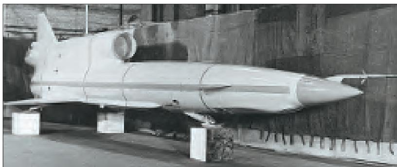
БПЛА Ту-141 с различным исполнением носовой части (в зависимости от состава разведывательного оборудования)
