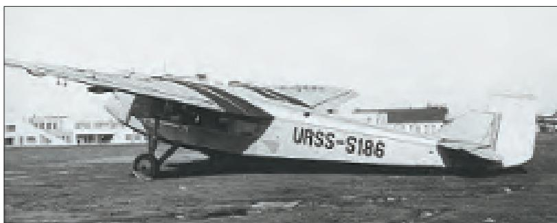
ПС-9 2 М-17 «Крокодил». Для участия в работе агитэскадрильи им. М. Горького был выделен один из серийных самолетов ПС-9 2 М-17. В честь сатирического журнала самолет был назван «Крокодил». Его внешний вид оформили соответствующим образом: он обрел обтекатели колес; удлиненную носовую часть фюзеляжа, декорированную под крокодилью морду; два ряда зубцов по верху фюзеляжа.
