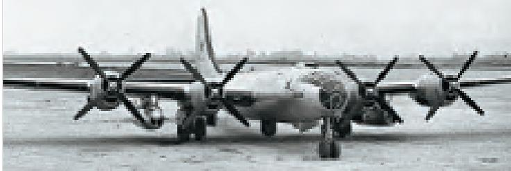
Ту-4Д – десантно-транспортный самолет – переоборудованный серийный Ту-4 выпуска завода №23 (с/н 2303201) с грузовыми подвесными кабинами под крылом
