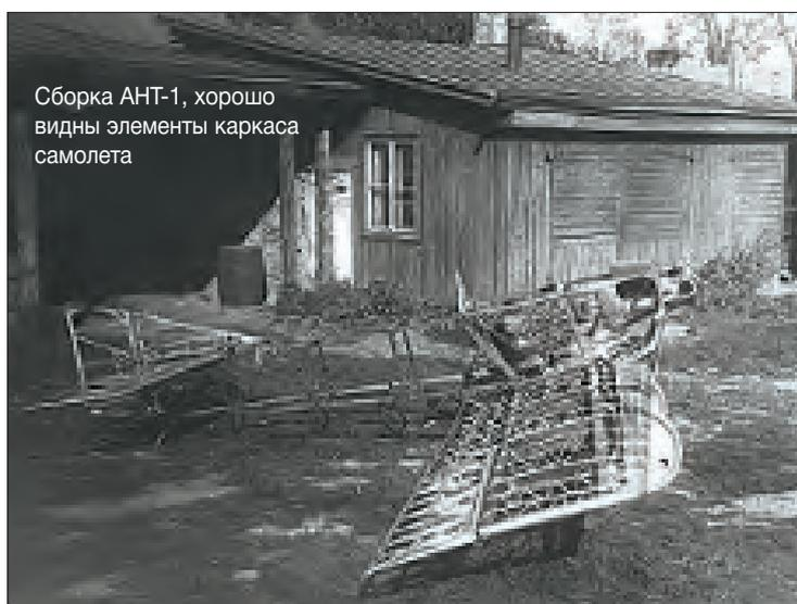
Сборка АНТ-1, хорошо видны элементы каркаса самолета
