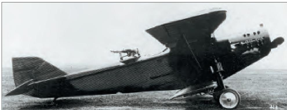
Р-3 ЛД (с двигателем Lorraine-Dietrich) на испытаниях, 1928 г. Заводом № 22 в Филях было построено и передано ВВС РККА 79 самолетов Р-3 ЛД
