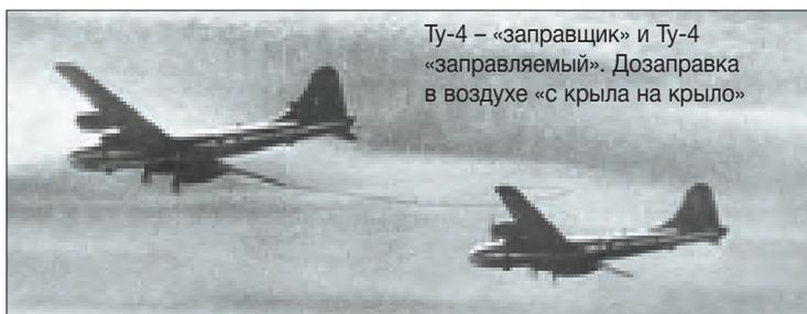
Ту-4 – «заправщик» и Ту-4 «заправляемый». Дозаправка в воздухе «с крыла на крыло»
