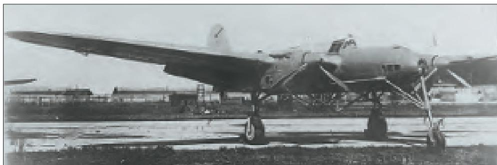
ММН с двигателями М-105 и трехлопастными винтами ВИШ-26, получивший прозвище «Щука» за рыбообразную носовую часть. Испытания в НИИ ВВС, июль 1939 г.
