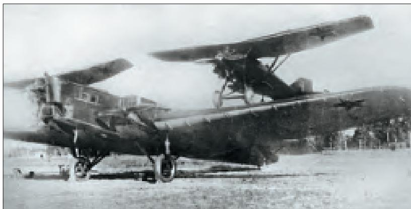
ТБ-1 со стартовыми ускорителями. В 1933–1934 годах на двух серийных самолетах ТБ-1 проводились эксперименты по применению стартовых твердотопливных ускорителей.
