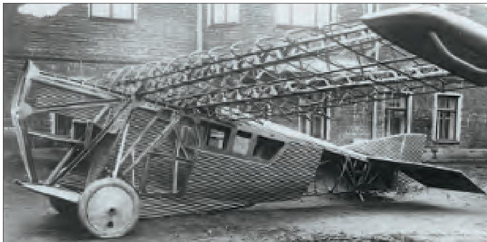
нонессущего цельнометаллического моноплана с верхнерасположенным крылом. На первую опытную машину был установлен двигатель Bristol Lucifer мощностью 100 л.с.
