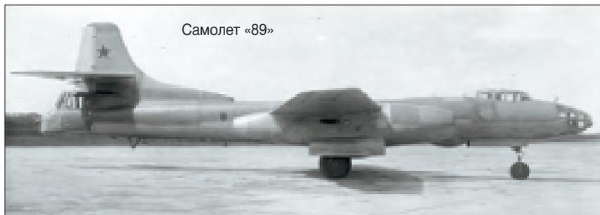
Согласно Постановлению Совета Министров СССР № 2474-974 от 10.06.1950 серийный самолет Ту-14 производства завода № 39 подлежал переоборудованию в самолет-фоторазведчик «81-Р», впоследствии этот проект по КБ получил обозначение самолет «89», официальное – Ту-16 2 ВК-1.
