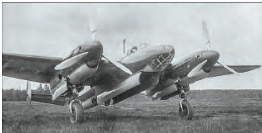
Самолет «103», заводские испытания, 1941 г.
