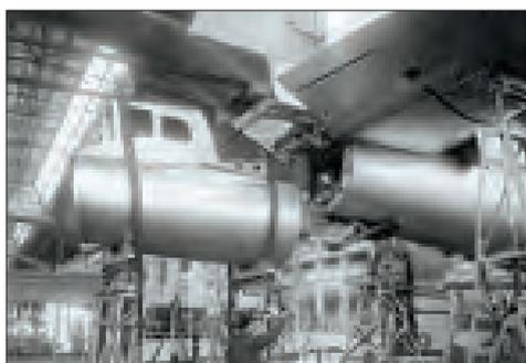
Стыковка агрегатов самолета Б-4 на заводе № 22
